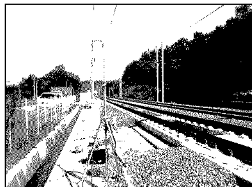
그림 3. 콘크리트 궤도 측정지점 (개활지 구간 시험부설선)
