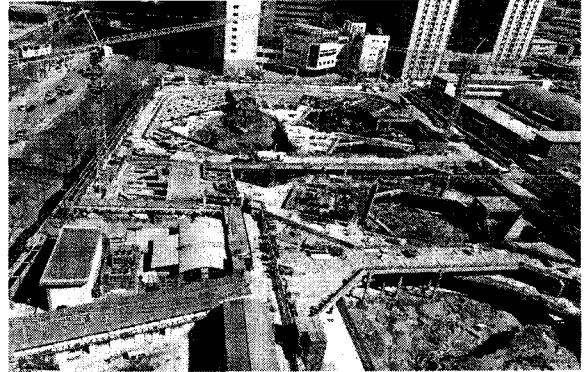
그림 3. 중국 상하이 J건설현장 아일랜드오픈컷 역타공법
