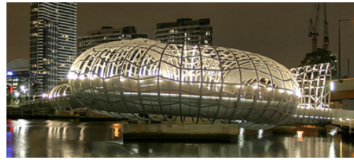
그림 3. 면 요소를 이용한 교량형태
