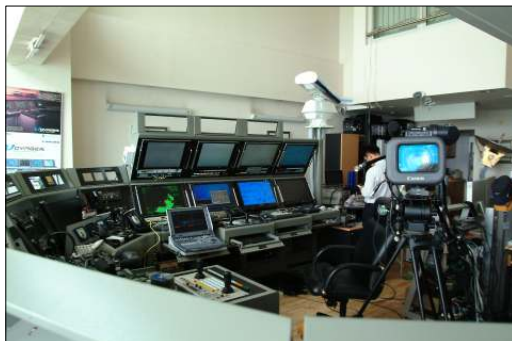
그림.7 IBS 설치 사진
