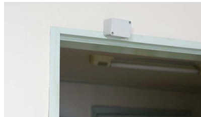
그림 3. 센싱 모듈 설치 위치
