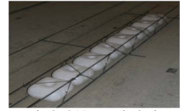
a)스페이서형 b)상하부근 일체형 그림2. 중공형성체 고정 방식
