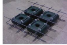
a)스페이서형 b)상하부근 일체형 그림2. 중공형성체 고정 방식
