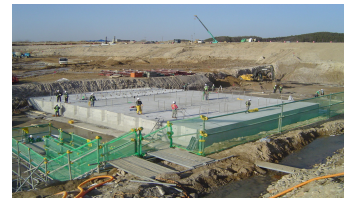
그림3. 기초 1단 타설 후 전경
