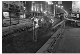
그림 2. 하부지반 평탄화 작업
