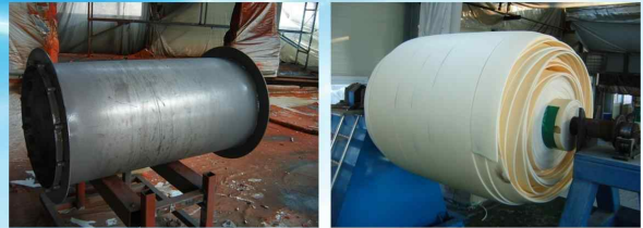
Pipe 용접 및 Polyurea 도장
