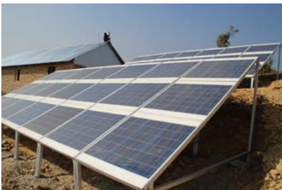
Fig. 2 프레임 및 배터리 하우스 설치 모습
