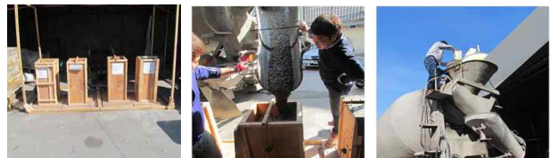
a) Mock-up 부재 b) 부재타설 c) 혼화재 투입 사진 1. Mock-up 부재 및 타설사진
