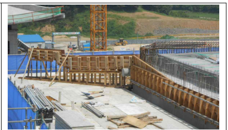
그림 5. 수평상판설치 모습
