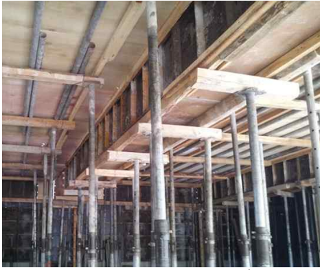
그림 1. 기존 거푸집 설치 3)
