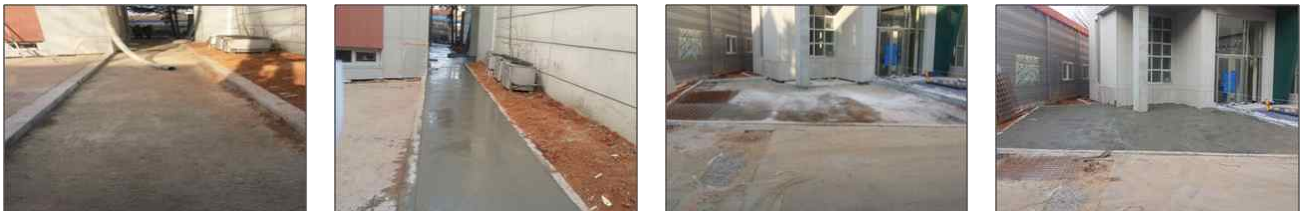
그림 1. 비정질 강섬유 보강 콘크리트 실증하우스 적용
