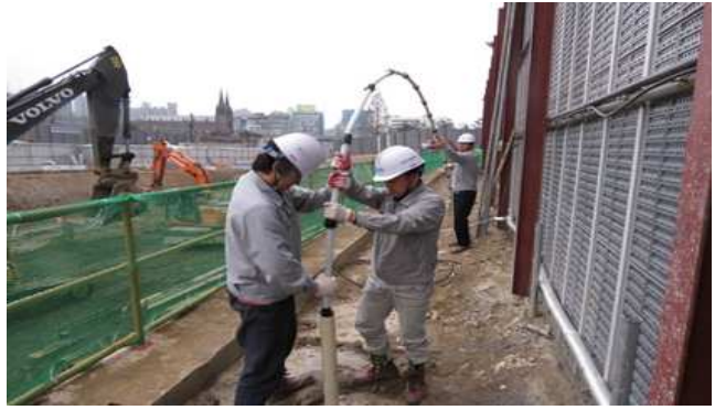
사진 2. 현장에서 SAA를 매립하고 있는 모습
