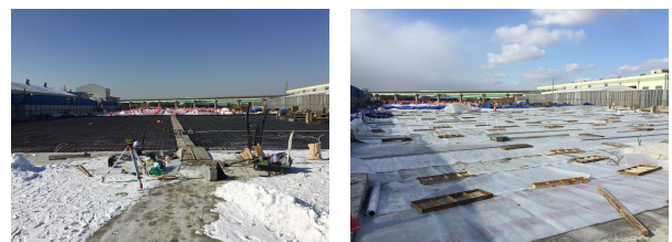
사진 1. 이중버블시트 포설 전 후 전경
