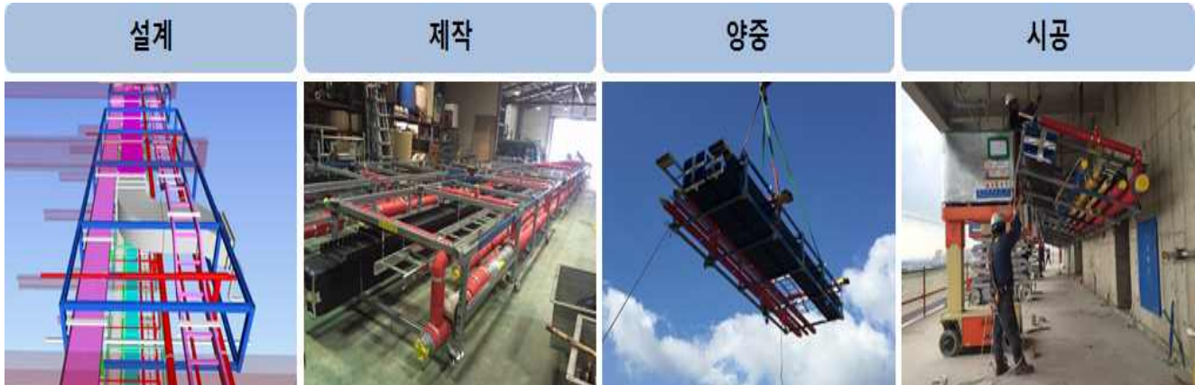
그림 1. Multi-trade Prefabrication 적용 단계 (현대자동차 일산복합거점 프로젝트)
