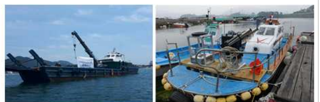
차도선 (길이 30m) 크레인차 설치
