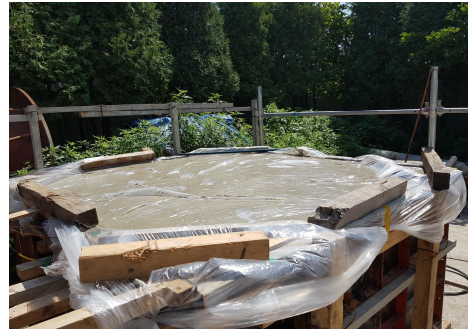
그림 2. Mock-up test 부재의 타설 후 양생
