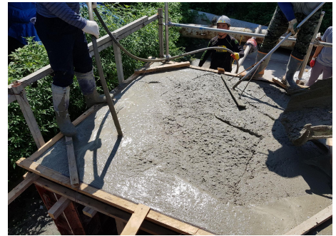
그림 1. Mock-up test 부재의 슬래브 타설
