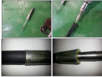
고정핀 삽입 - 스크류방식 고정핀 압착 - 오일 호스압착기
