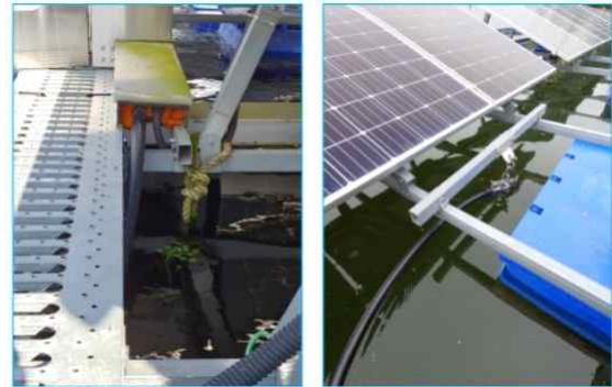
그림 4 수상태양광시스템의 DC접속함 인출선
