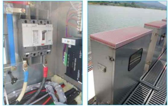
그림 3 수상태양광시스템의 DC 접속함 내부 및 외부
