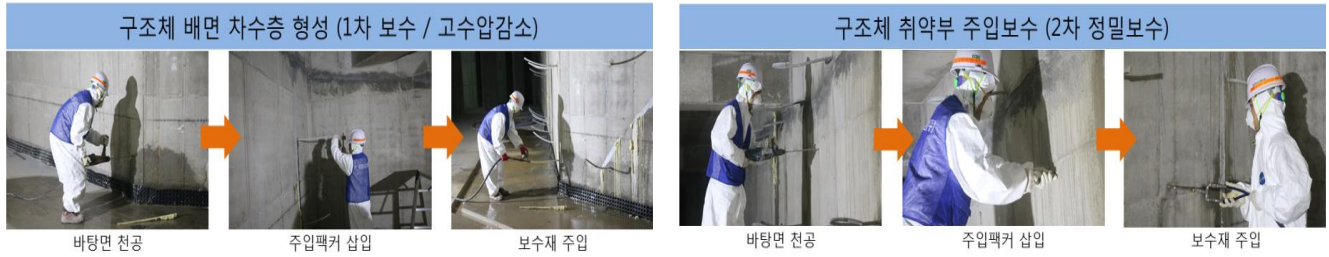
그림 1. PAG 복합 누수 공법 시공 순서
