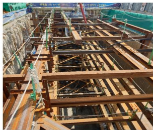
최상부 철골보 설치 사진
