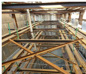
중앙부 철골보 설치 사진
