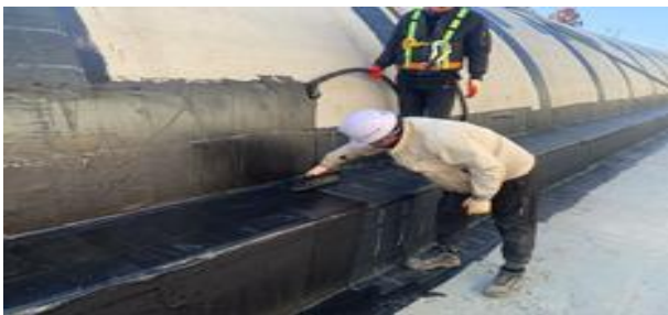
그림 3. S.R.P.G 방수 시공 현황
