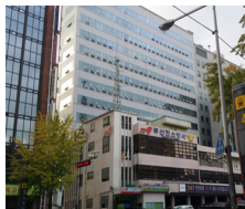
(c) Jack Pile 시공
