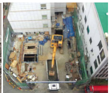
(b) Jack Pile 시공
