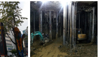
(d) Jack Pile 시동
