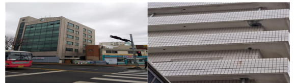
그림 3. 제주시 삼도1동의 공사중단 건축물
