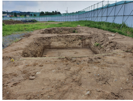
그림 2. 터파기 및 그 주위의 가설울타리
