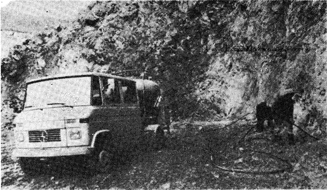
<그림-5> AN-FO charger 에 의한 Charging
