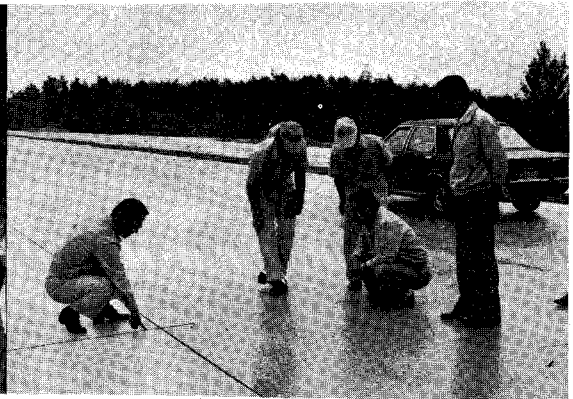
줄눈施工 點檢
