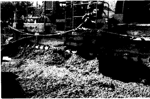
<사진-3> Slipform paver 에 의한 포장판 작업전경
