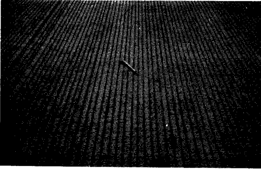
〈사진-7〉 준조강시멘트 콘크리트의 Tinning 처리 상태
