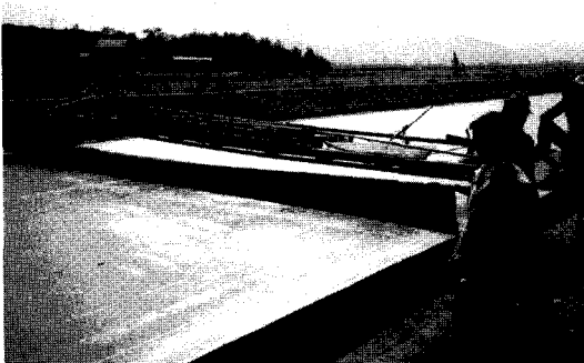
<사진-5> Slipform paver 작업 후 Burlap으로 콘크리트 표면처리 작업전경
