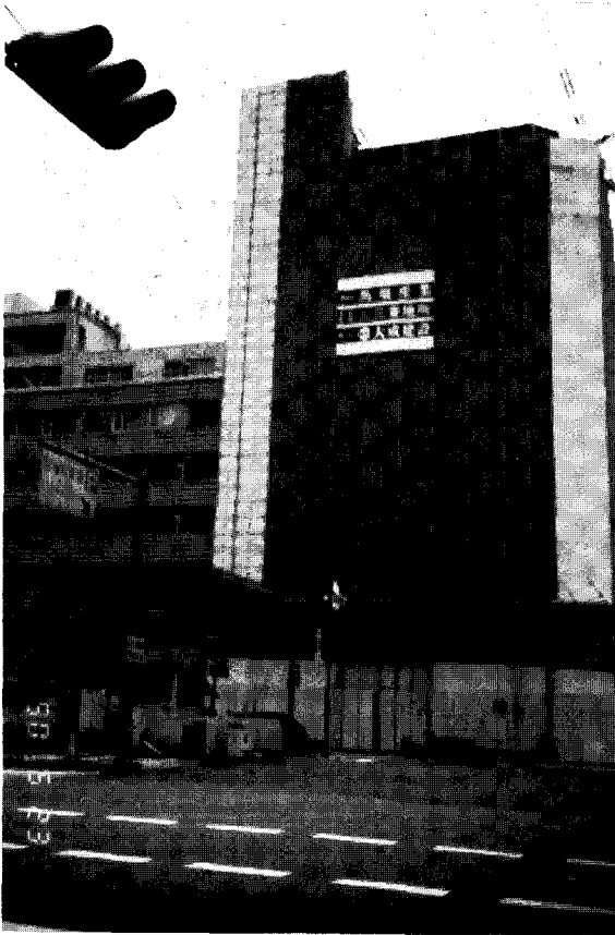
얼핏 보아 건설현장이라는 느낌이 전혀 들지 않는 건설현장
