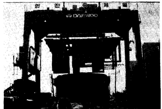
[사진-5] PC Module의 탈형
