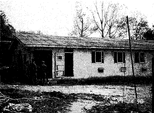
〈사진 11〉 착유우사의 측면구조(아래 환기구와 넓은 창을 설치했으나 창문이 반밖에 열리지 않는 것이 아쉽다)
