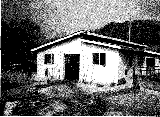
〈사진 9〉 나중에 지은 듯 한 착유우사(환기 효과를 높이기 위해 모니터형 지붕을 채택했다)
