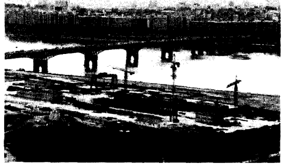
사진 1. 교량상판 Segment 제작장 전경
