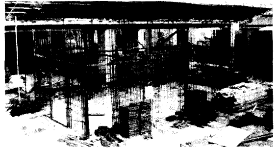
사진 5. Core Wall 철근 Prefab
