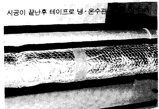
협소한 공간 및 엘보, 티 등 이음부분의 많은 배관에도 쉽게 시공이 가능한 철망보온단열재.
