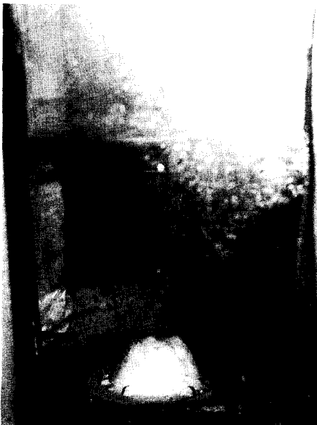
Fig. 7 Icing cap formation on the LNG injection nozzle surface
