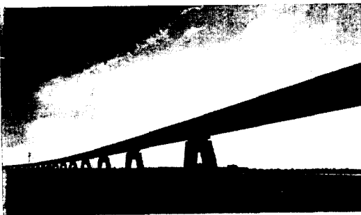
그림 24. 자기부상식 열차는 콘크리트 支持臺위의 트랙에서 주행하므로 토지점유율이 매우 작다.
