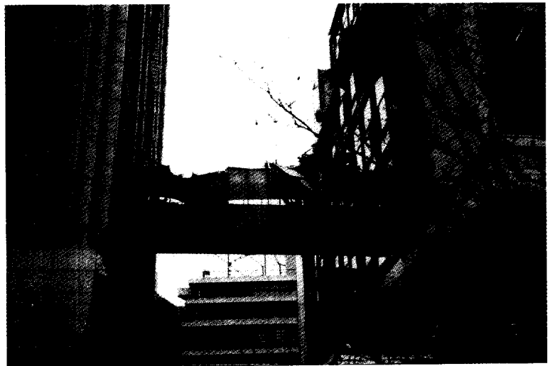
〈서로 다른 주기를 갖는 건물에 연결된 다리의 파손〉
