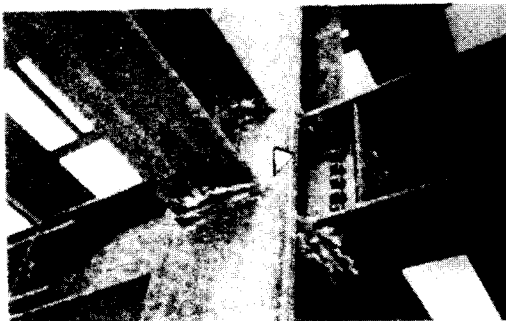
사진 3.1.1 용접봉이 삽입된 기둥보 현장용접 접합부
