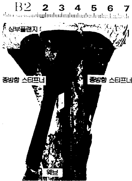
그림 10. 상부플랜지와 웹의 모살용접부에서 발생한 균열
