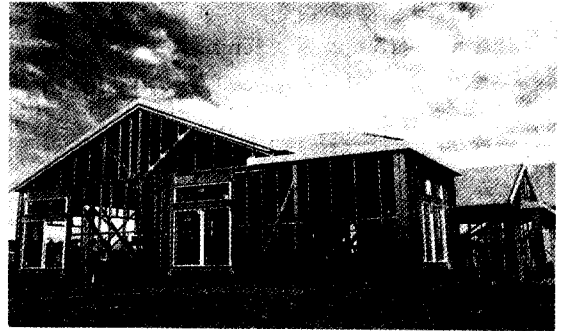
그림 1 LGSF Housing 골조공사 장면
