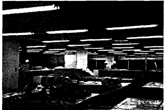
[사진 2] 금요일의 작업전의 양생작업
