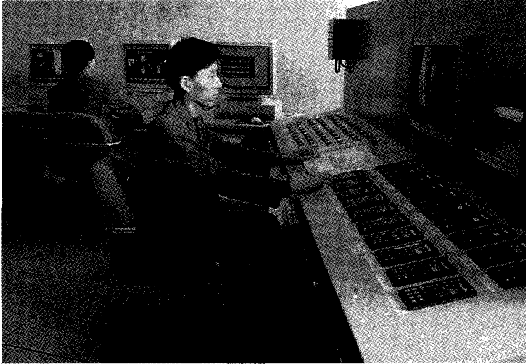
분산제어시스템(DCS)에 의한 시험연소로의 운전
