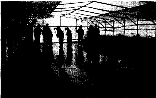
접착층 시공 광경
