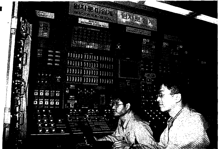
월성 원전 중앙제어실. 월성 원전 정보 공개시스템은 PC 컴퓨터와 PC 통신을 이용한 새로운 정보 통신 기술 방식인 엑스트라넷 방식을 이용하여 구축되었다.
