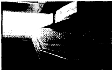
【사진2】 계단 측면의 돌출 손잡이와 방향유도 기능의 띠처리
