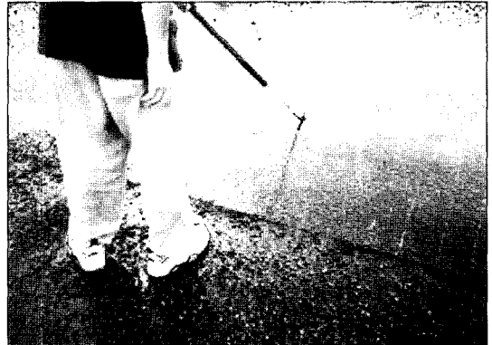
사진 18. 블리스터링이 발생한 부분의 공기제거
