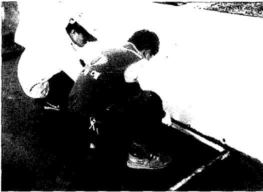
사진 14. 성형줄눈 설치
