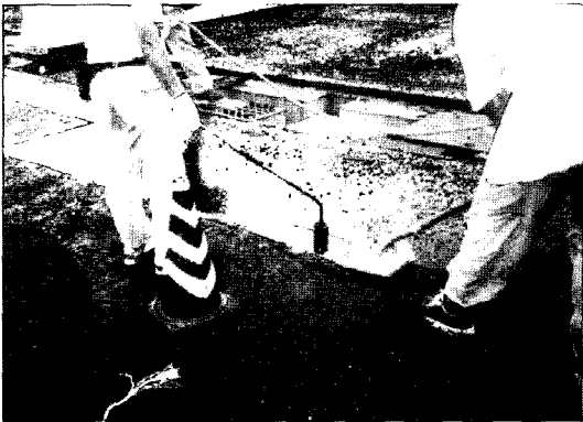
사진 17. 흙손의 가열 및 표면 마무리작업
