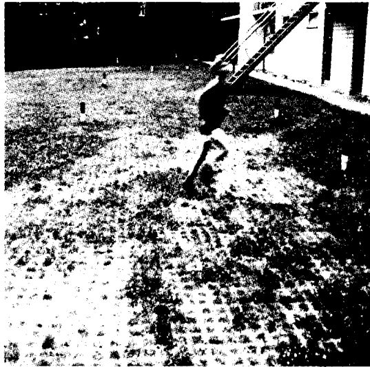
〈그림 9〉 차량 통행이 가능한 잔디 블럭
