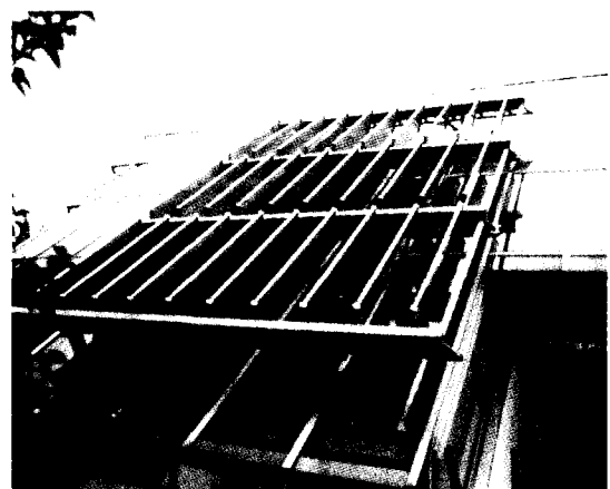
〈그림 1〉 태양열 집열판의 설치
