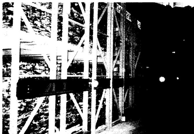
<사진 3> 이동력이 설치된 냉장실
